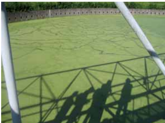
Das stillgelegte Klärbecken der Kläranlage Bernemündung wird zukünftig neu genutzt werden.
