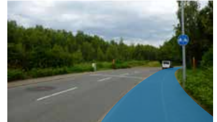
Kombinierter Geh- und Radweg: Für den Fußgängerverkehr muss Ersatzraum geschaffen werden.
