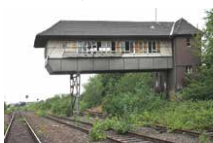
Reiterstellwerk Bahnhof Essen Nord
