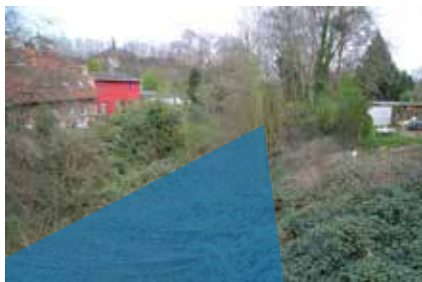
Vor dem Neubau des Radschnellwegs muss die Trasse geräumt und vorbereitet werden.
