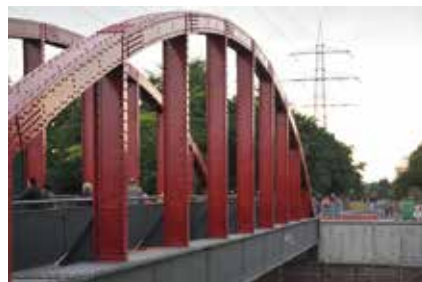
Brücke Helenenstraße, Essen (nach Umbau zum Radweg)
