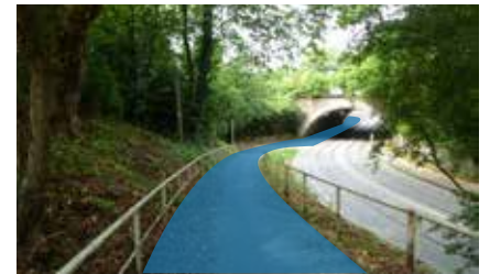
Das Gefälle und die Engstelle durch das erhaltenswerte Brückenbauwerk müssen berücksichtigt werden.
