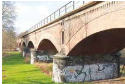
Ruhrbrücke Mülheim an der Ruhr – Vorlandbrücke am linken Ruhrufer
