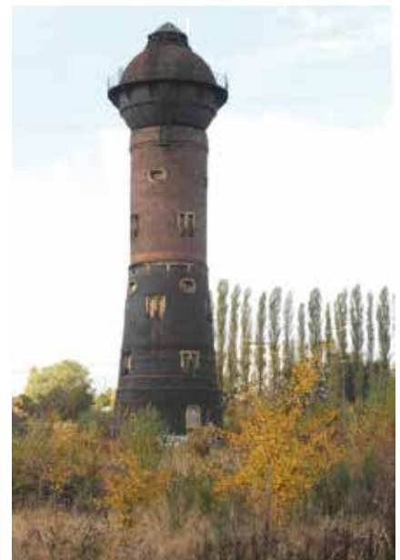
Wasserturm des ehem. Rbf Wedau
