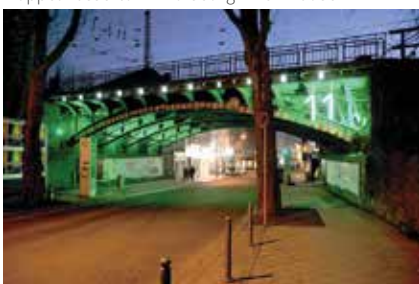
Bochumer Stahlbrücke (Tor 11 – Kortumstraße)
