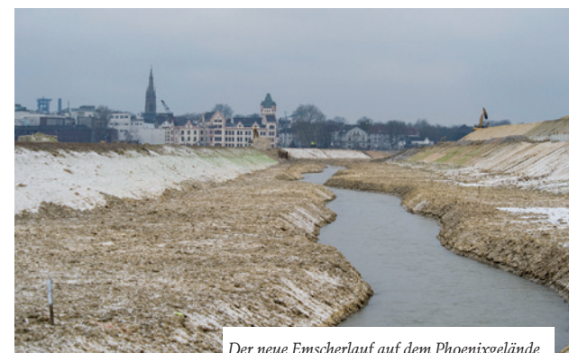
Der neue Emscherlauf auf dem Phoenixgelände
