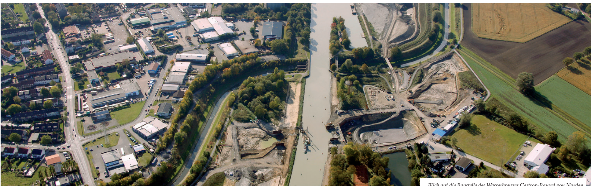
Blick auf die Baustelle des Wasserkreuzes Castrop-Rauxel von Norden
