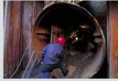
Großbaustelle Kanalbau in Duisburg-Stockum. Foto: Klaus Baumers / © EGLV Fotoarchiv
