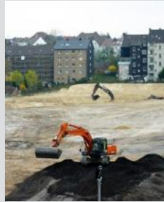
Großbaustelle Phoenixsee. Foto: K.-H. Blomann / © K.-H. Blomann
