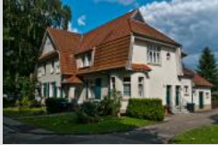
Die Siedlung Teutoburgia in Herne wurde im Rahmen der IBA Emscher Park modernisiert. Foto: Michael Becker (CC)
