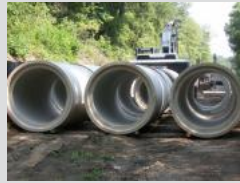
Abwasserkanäle. Foto: © Emschergenossenschaft
