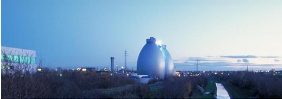
Kläranlage Dortmund-Deusen, Foto: © 2md
